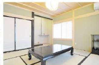
柱を見せた真壁の本格和室。構造から自出したつくりなので、将来的に「洋室」に変更または「場所を移動させる」ことも可能だ
