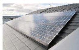
太陽光発電システムは3.28kwの出力を持ち、光熱費を大幅に削減している
